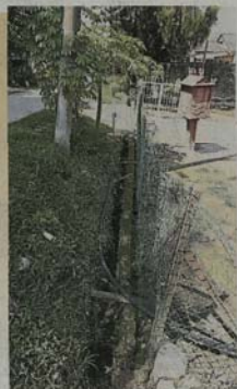
梳邦新村的溝渠陳舊及年久失修，不能負荷大量的雨水，每當下起大雨，雨水就會滿溢至路面。
